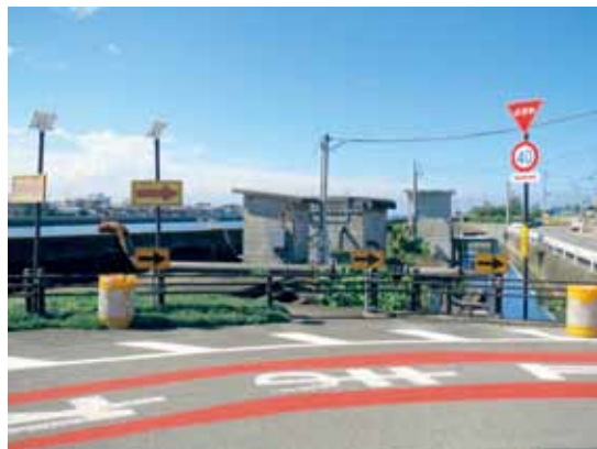
▲排水対策が進む有明ポンプ場
