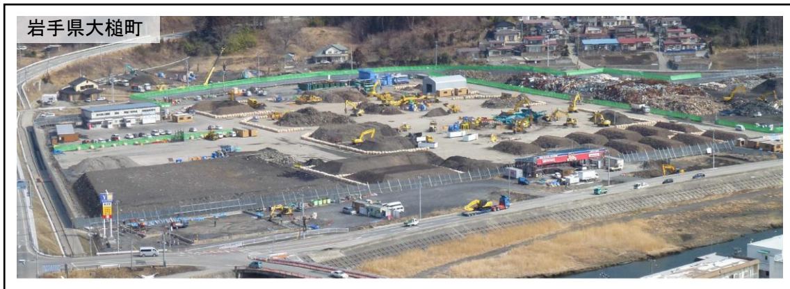
図 2-6-(10)-3 二次仮置場の例
