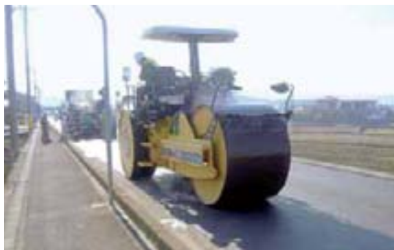
▲市道の舗装工事
