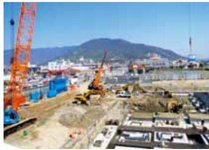
新庁舎建設工事
