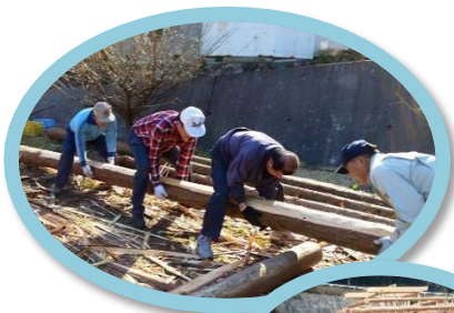
水車小屋の建設
