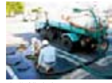
浄化槽内部にたまった汚泥の抜き取り
