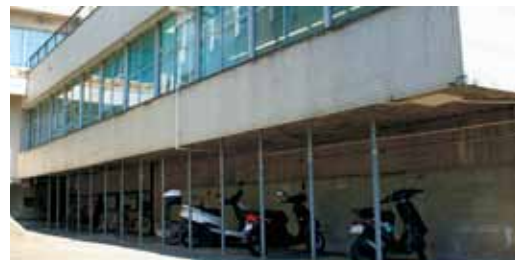
▲庁舎を大量のポスト支柱で補強
