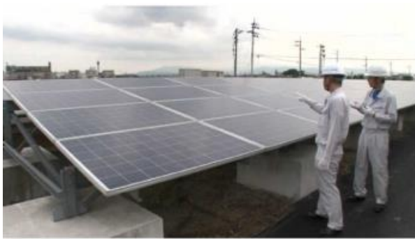
太陽電池モジュールの外観検査
