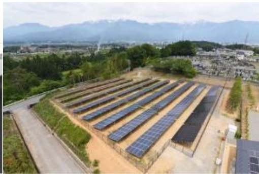
リユース品を使用した発電所
