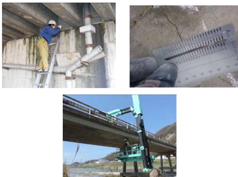
図 3.1 定期点検の様子
