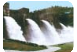
大野原町 「豊総池石積式アーチダム」
