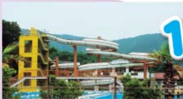
観音寺市立ファミリープール
