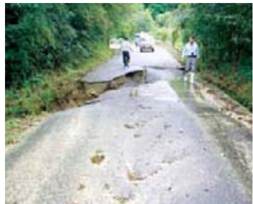
▲被災した林道五郷財田線
