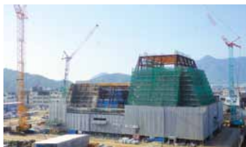
▲建築中の新市民会館（5月末段階）
