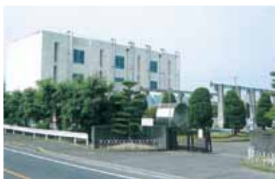
▲第一ポンプ場
