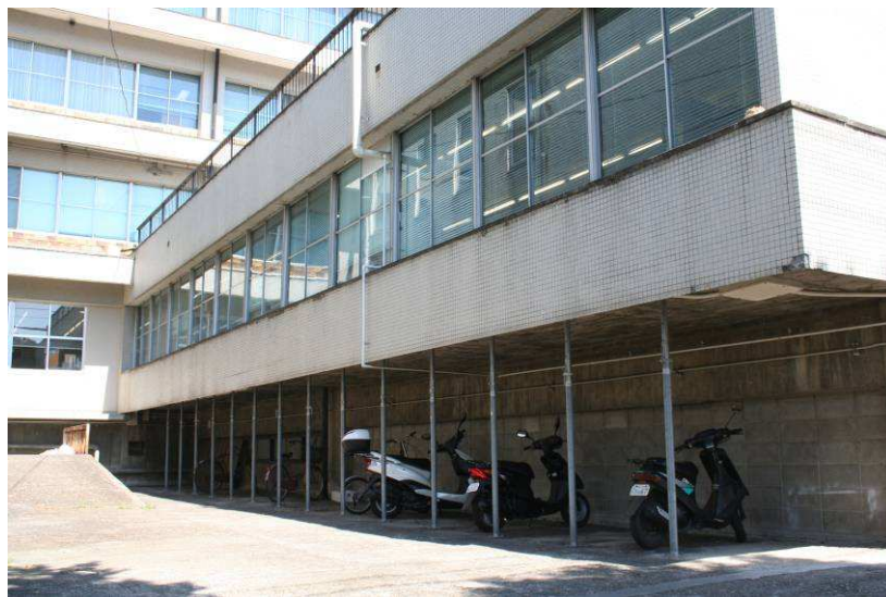
庁舎を大量のポスト支柱で補強
