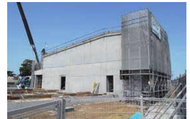
▲建設中の観音寺中央幼稚園
