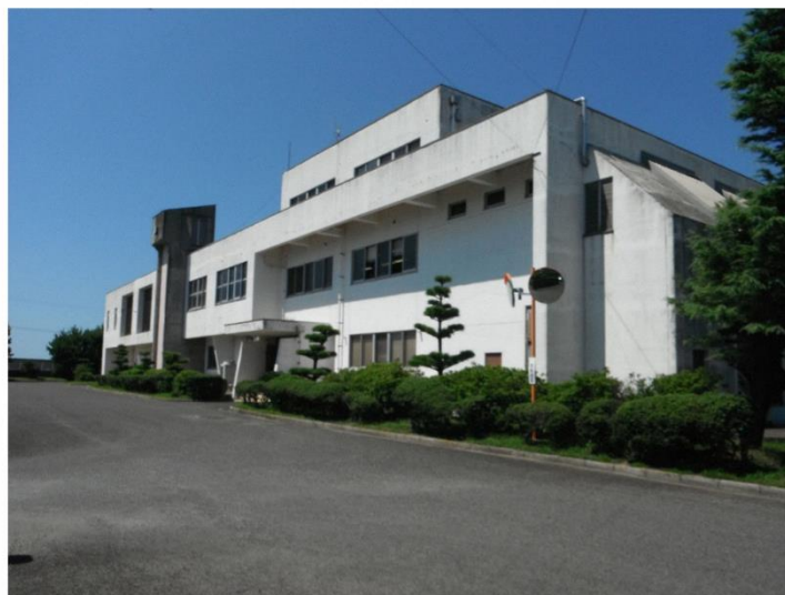
観音寺市下水浄化センター
