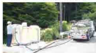
海老済石砂地区に小型貯水槽と給水車を整備
