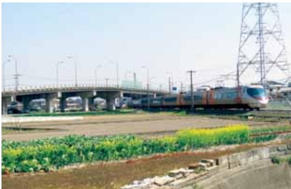
▲JRと交差する坂本跨線橋
