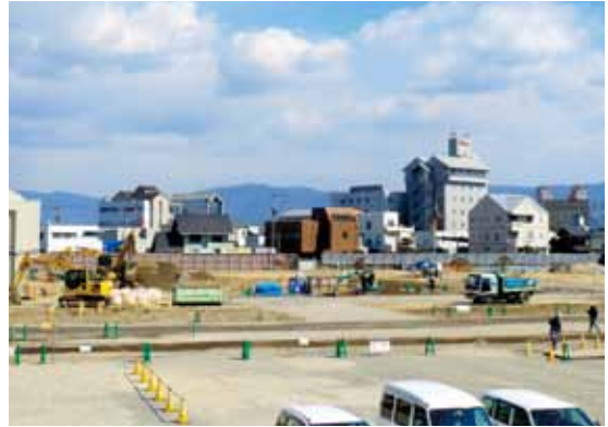
▲基礎工事中の建築現場（3月段階）
