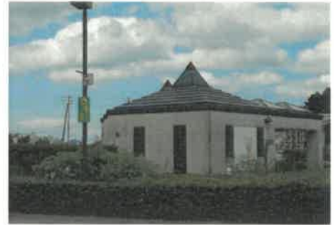
写真5-77 大野原中央公園 トイレ
