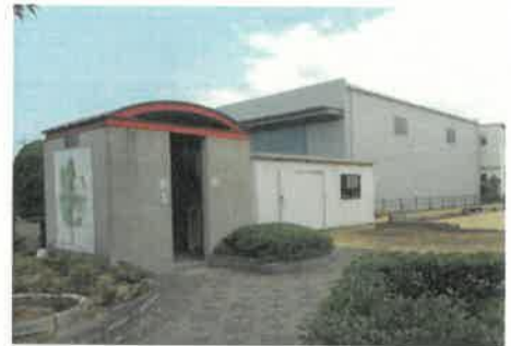
写真5-79 大野原中央公園 トイレ
