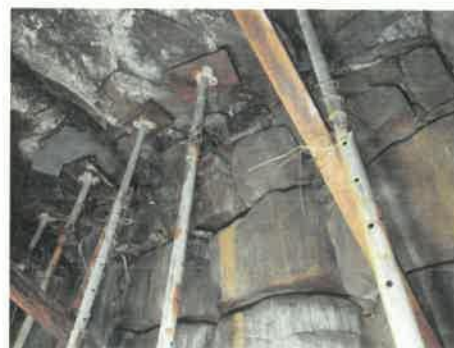
写真5-69 鉄製パイプと木製受け部
