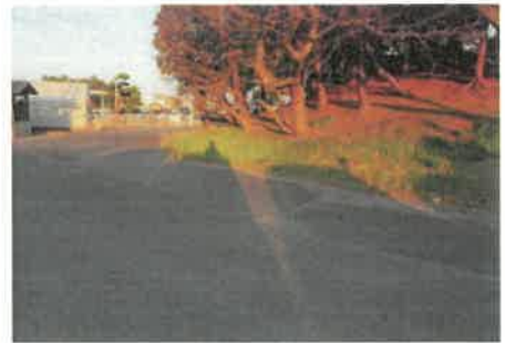
写真 5-18 周溝範囲上のアスファルト舗装路
