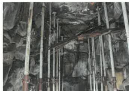
写真5-15 椀貸塚古墳石室内の支保工
