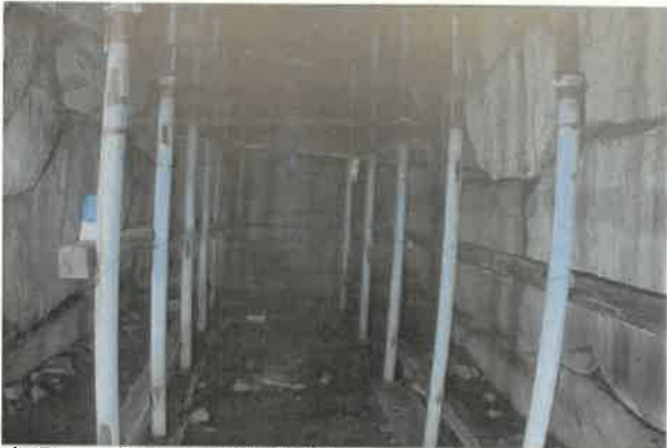
振動レベル設置状況 (玄室)
