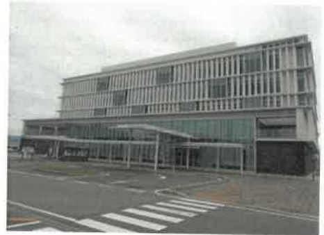
写真-1 観音寺市役所
