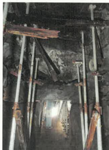
写真5-68 支保工の劣化状況
