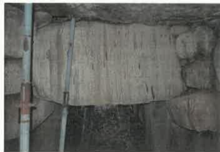
写真5-71 傾いた支保工
