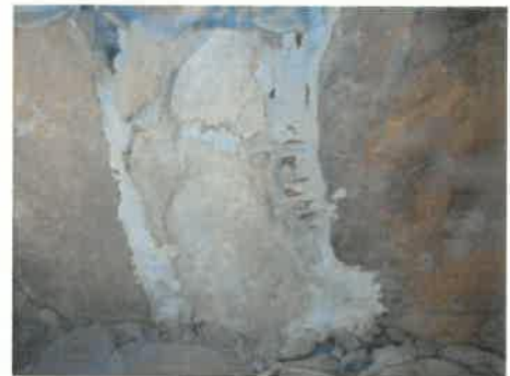
写真5-51 充填されたモルタルと木材
