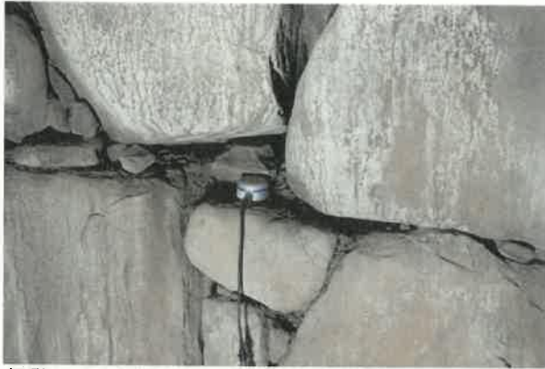
振動レベル設置状況 右側壁玄室奥壁側 203
