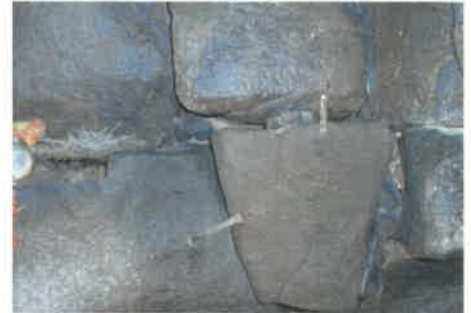
写真5-10 設置されたガラス棒
