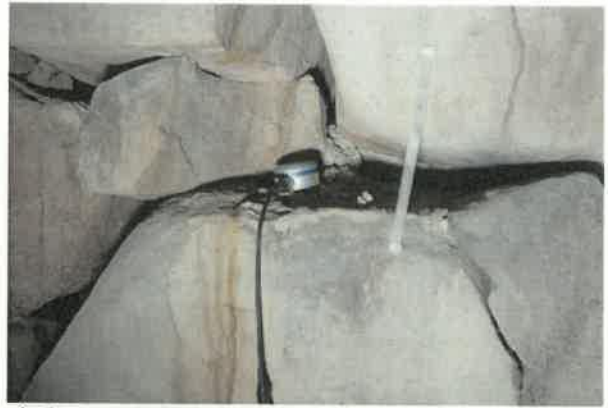
振動レベル設置状況 右側壁義道玄門側 210
