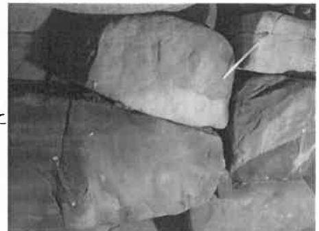
写真5-37 設置されたガラス棒
