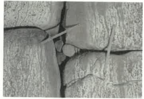
写真5-25 設置されたガラス棒
