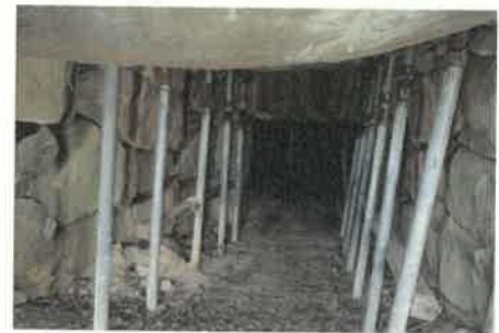
写真5-27 平塚古墳石室内支保工
