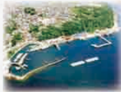
▲整備が進む伊吹漁港
