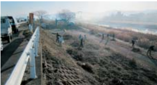
朝早くからの作業、お疲れさまでした
