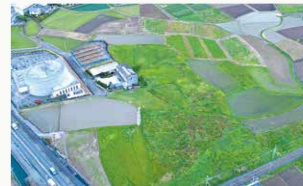
建設候補地の現在の様子
