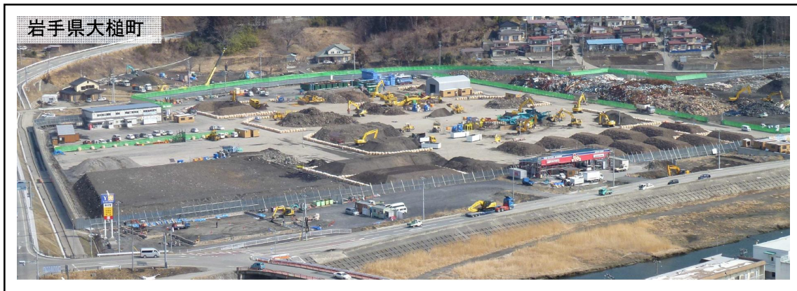
図 2-6-(10)-3 二次仮置場の例
