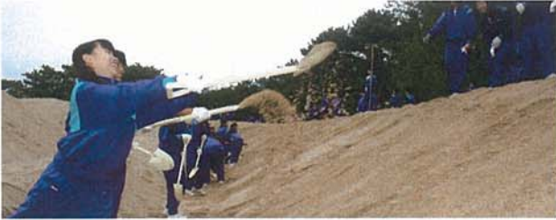
▲ 雨を含んだ砂は重い
