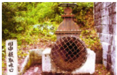
旧中樋取水バルブ
