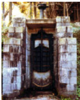
旧土砂吐樋門
