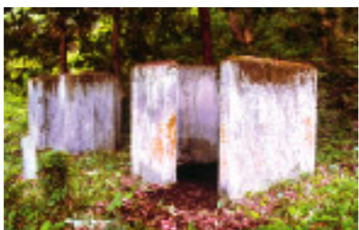
旧火薬貯蔵庫
