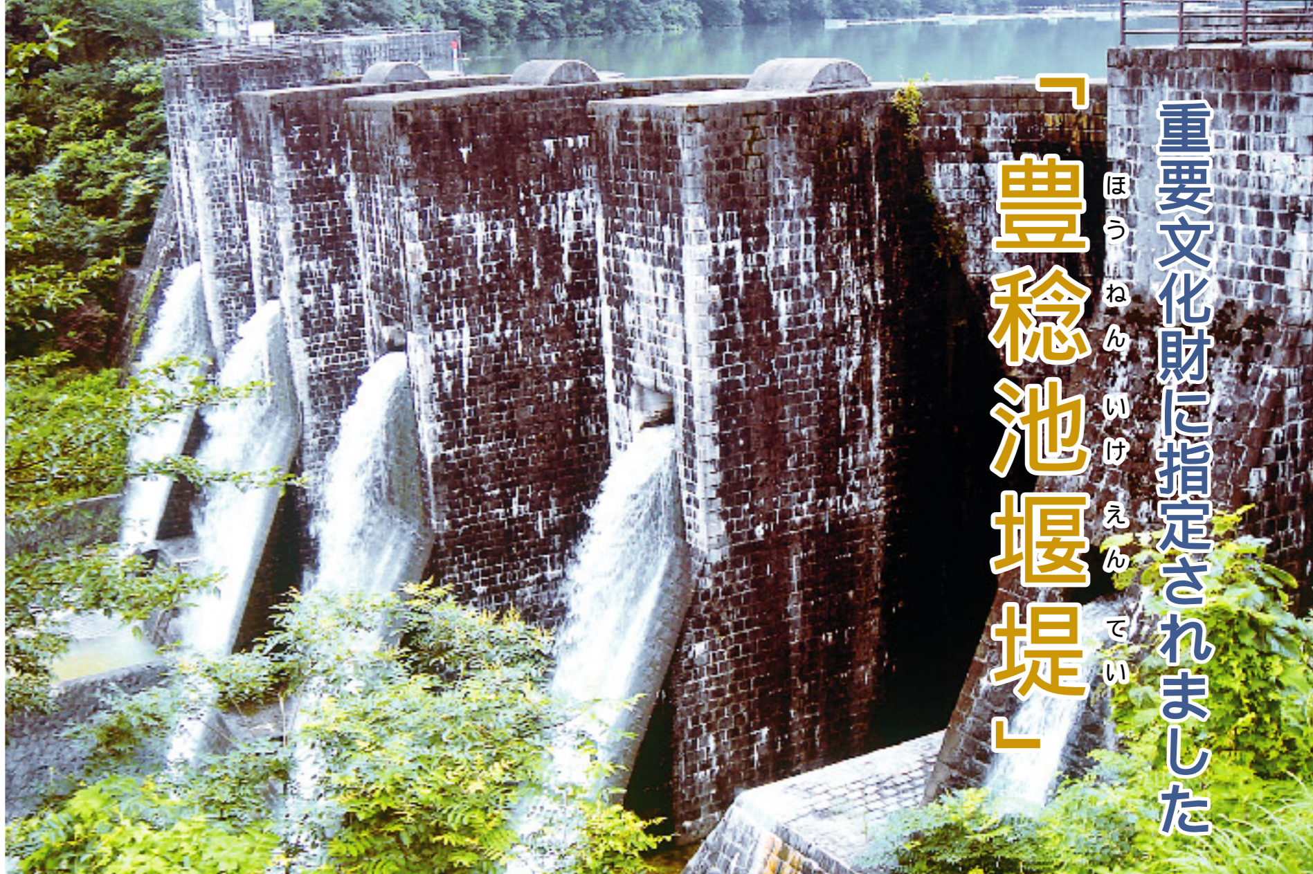
豊稔池堰堤 H18 .7 .23 撮影
