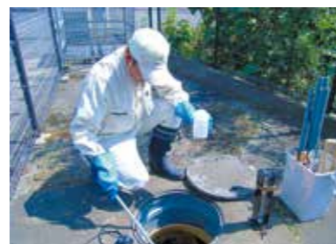
法定検査の様子
