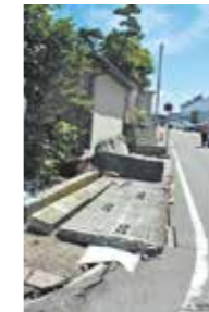
出典： （一財）消防防災科学センター （災害写真データベース）
