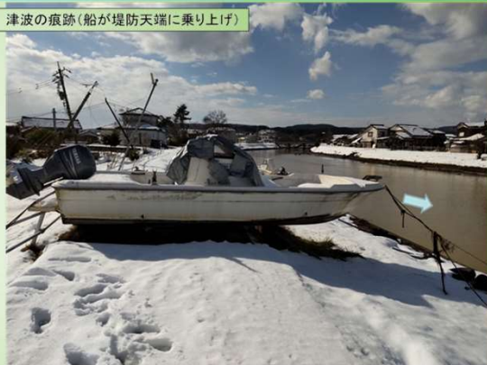
鵜飼川 津波の痕跡(船が堤防天端に乗り上げ)
