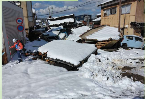
鵜飼川右岸付近(道路が家屋倒壊で通行不可)
