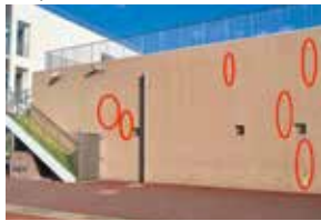
観音寺小学校プール
