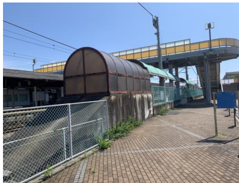
図表 43 観音寺駅の南北をつなぐ跨線橋
