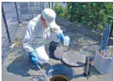
法定検査風景
