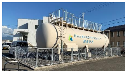
▲耐震性貯水槽
