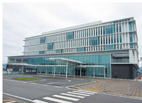
写真2-1 観音寺市役所
