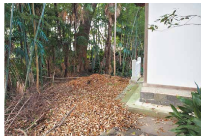
写真5-8 旧八幡宮本殿との重複部分周辺の状況
