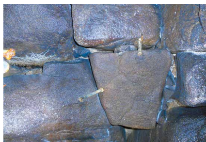
写真5-10 設置されたガラス板
