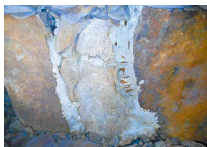
写真5-51 充填されたモルタルと木材
