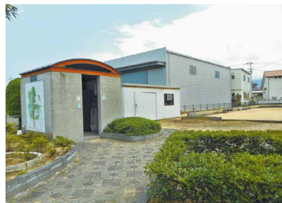
写真5-78 大野原中央公園 トイレ
