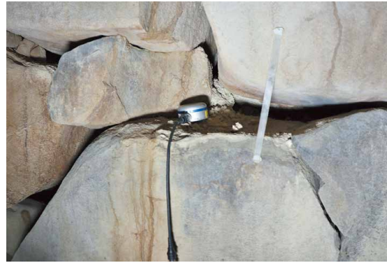
振動レベル設置状況 右側壁羨道玄門側 210
