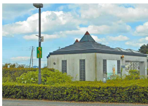
写真5-76 大野原中央公園 トイレ
