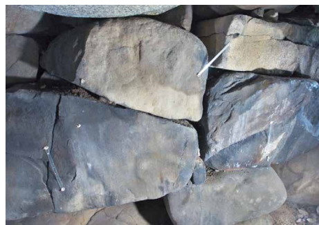
写真5-37 設置されたガラス板
