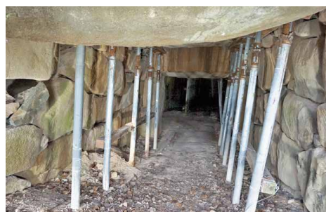
写真5-27 平塚古墳石室内支保工
