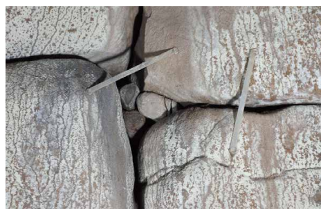
写真5-25 設置されたガラス板
