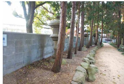
写真5-6 コンクリートブロック塀の敷設状況
