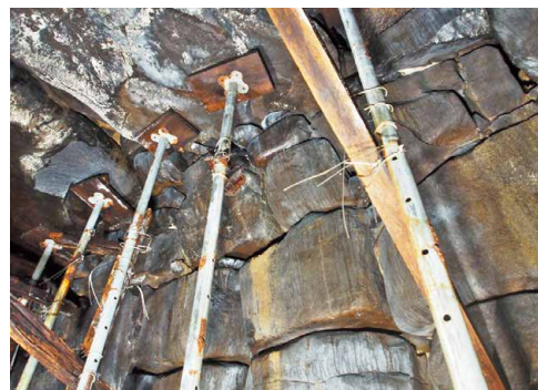
写真5-68 鉄製パイプと木製受け部
